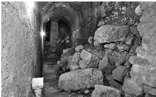
Fig. 20. Galleria retrostante l'abside: materiale di crollo
